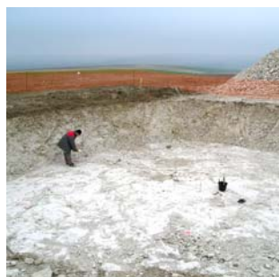
Tracage des repères du massif de fondation
