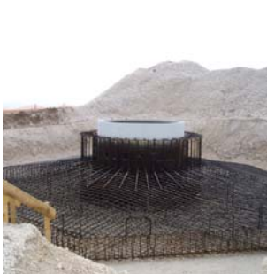
Ferraillage du massif : jusqu'à 24t d'acier
