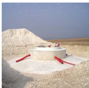
Fondation terminée: jusqu'à 200 m³ de béton
