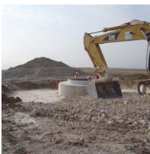
Remblaiement de la fondation
