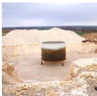
Préparation de la virole sur le béton d'étanchéité
