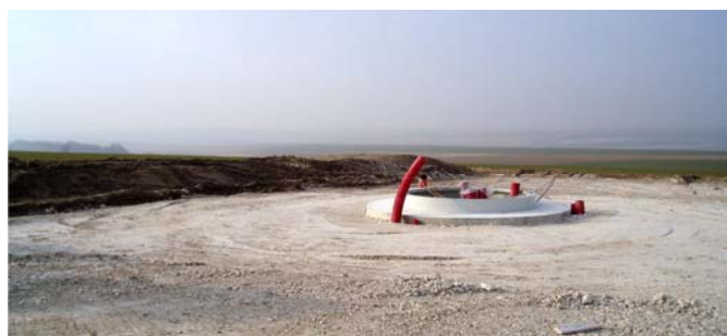
Fondation terminée et remblayée, prête à recevoir l'éolienne.
