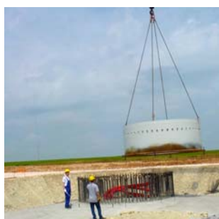
Pose de la virole, base de l'éolienne
