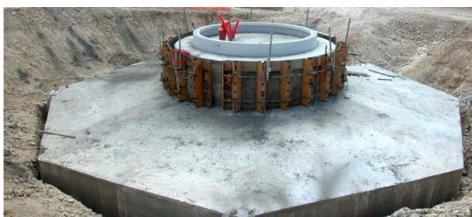
Fondation terminée, avec son coffrage. Tous les socles seront enterrés.
