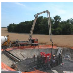
Coulage du béton pour le socle
