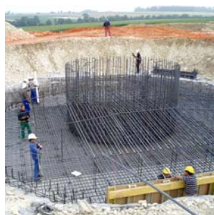
Mise en place du ferrailage
