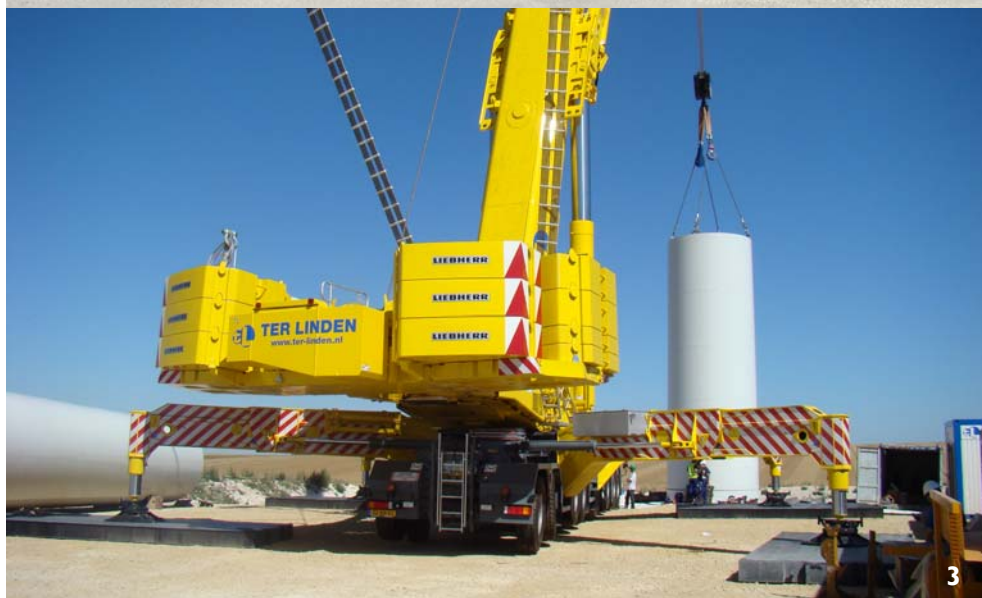
1 - Arrivée des pales de l'éolienne N° 18
