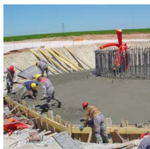
Finition : lissage du béton
