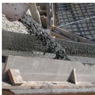
Il y a 300 m 3 de béton par éolienne
