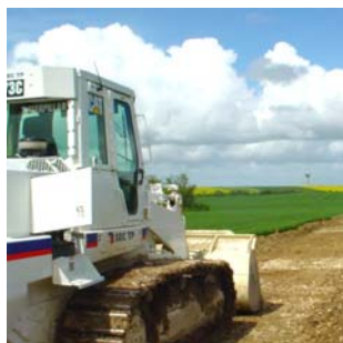
Création des accès aux éoliennes
