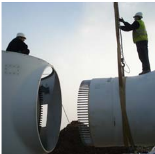
Montage du rotor
