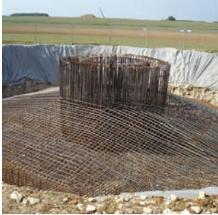
Ferrailage du massif de la fondation
