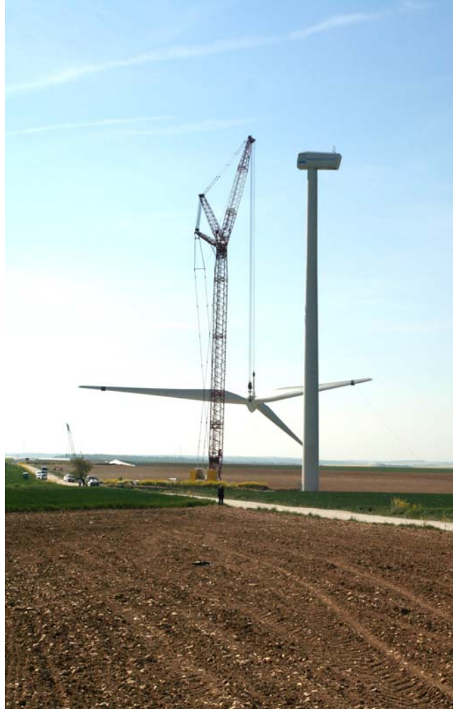
Dernière étape, la levée du rotor
